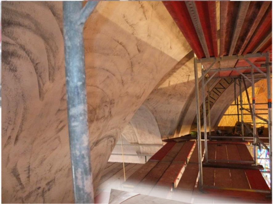
Beträchtliche Ablagerungen müssen mittels Spezielschwamm trocken entfernt, Putzschäden ausgebessert, die Flächen grundiert werden.
